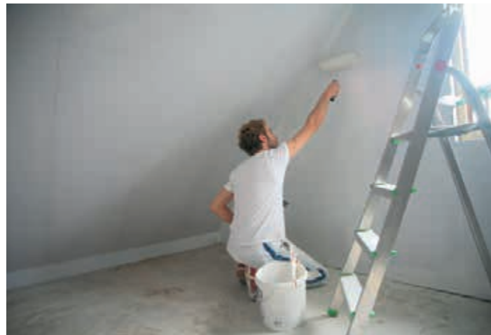
Zum Streichen von Wänden benötigt man große Rollen sowie kleine Pinsel für die Ecken, für die Decke eine Teleskopstange und eine standsichere Leiter Foto: Rainer Sturm/pixelio
